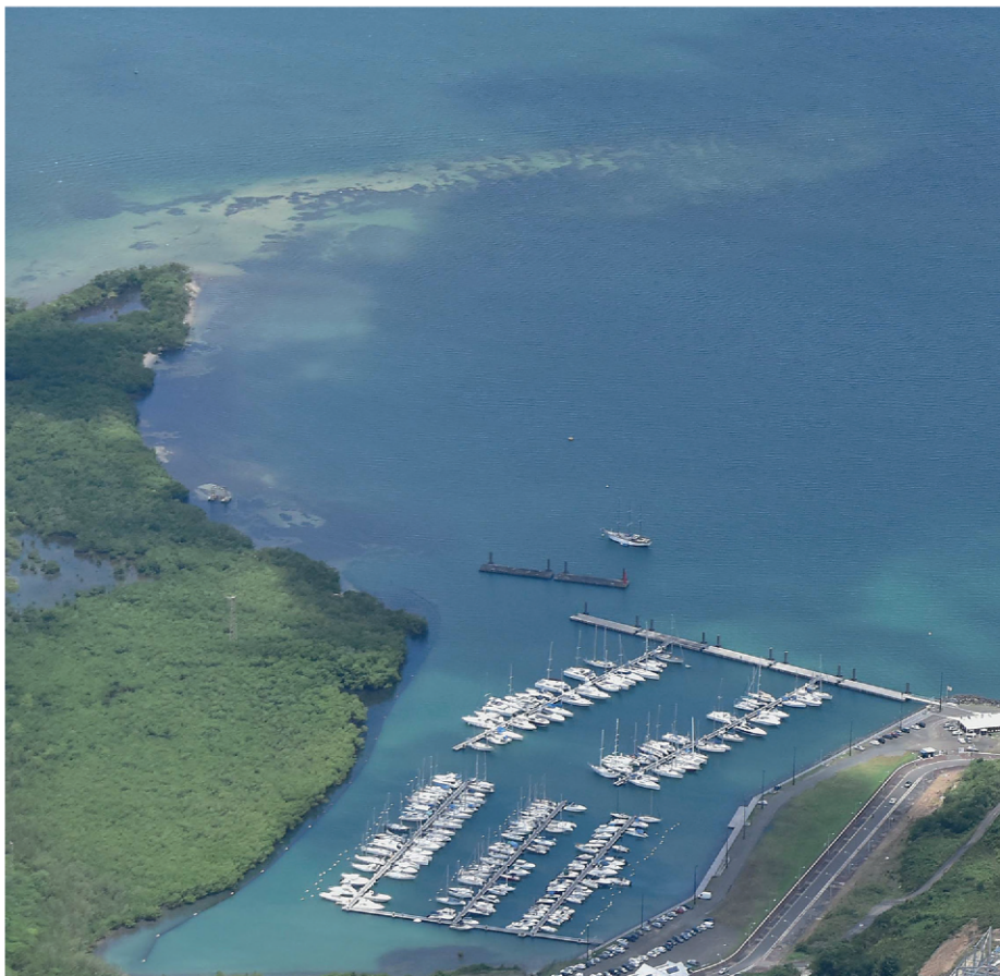
Vue vers la Pointe des Sables, lieu d'implantation du projet Z'AB depuis le port de plaisance de l'Etang Z'abricots (Ville de Fort de France) © Jean-François PRADAL
