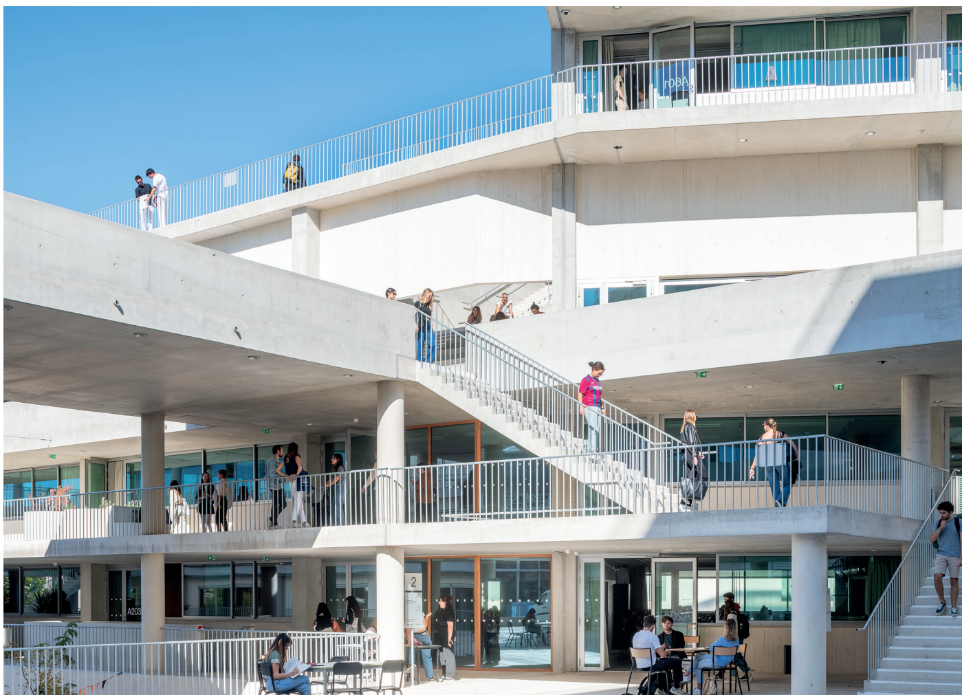
IMVT, Institut méditerranéen de la ville et des territoires. Après livraison et ouverture aux étudiants pour la rentrée de septembre 2023 Copyright : Geoffroy Mathieu/Oppic. Maître d'ouvrage : ministère de la Culture/ Maître d'ouvrage délégué : Oppic/ Maîtrise d'œuvre : Architectes : NP2F Architectes (mandataire) / Marion Bernard / Point Supreme / Odile Seyler & Jacques Lucan
