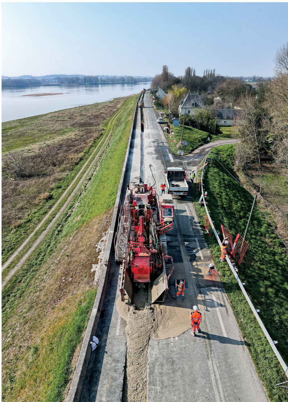
Deep Soil Mixing dans la levée du val d'Authion -> 2021-DREAL CVL/DETL ©Cédric Helsly
