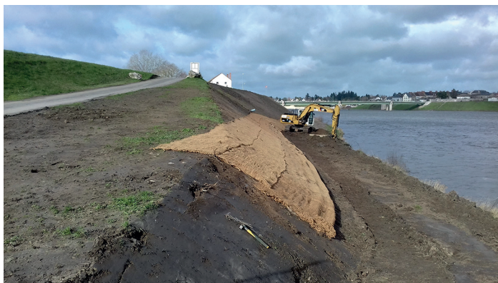
Restauration du talus de la levée d'Orléans à Jargeau ©2019-DREAL CVL/DETL
