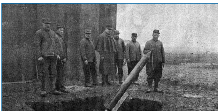
Figure 2. Canon à brai dans son emplacement (juin 1917) 5 . On notera l'inclinaison proche de 45° pour avoir un tir battant. 6
