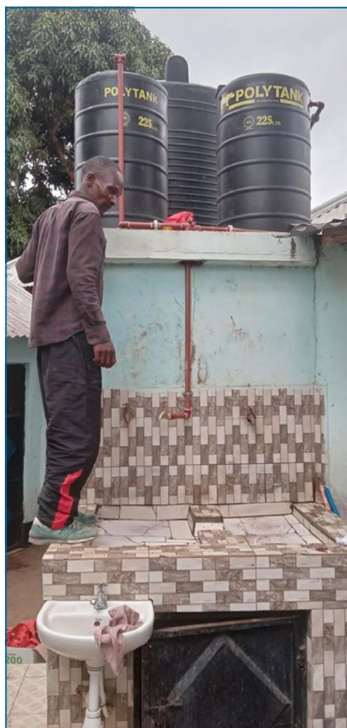
▲ Installation des réservoirs des filtres.
